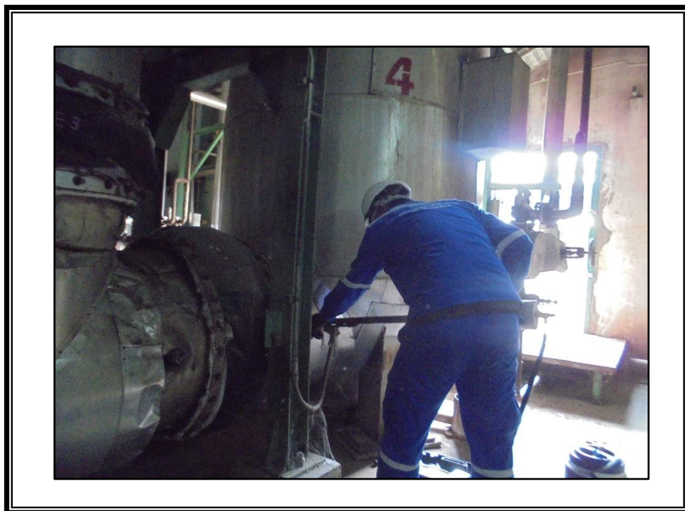
รูปที่ 3.2-1 จุดตรวจวัดคุณภาพอากาศจากปล่องปล่อยทิ้งอากาศเสีย บริเวณปล่อง Waste Heat Boiler ที่ต่อกับเครื่องยนต์ Caterpillar No.4 ในวันที่ 5 พฤศจิกายน พ.ศ. 2568
